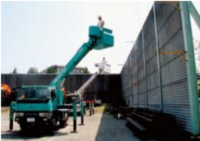
高所作業車運転技能講習
