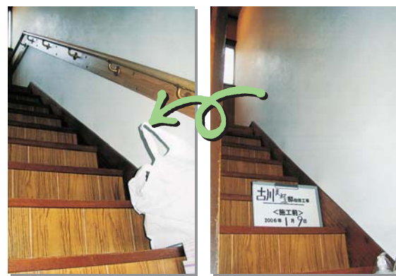
階段の手すり
