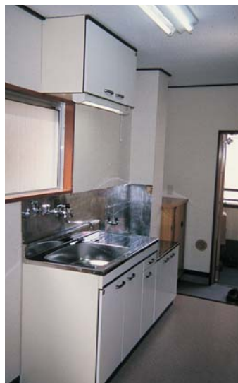
流し台と吊り戸棚を取付け、床・クロスの張替え
