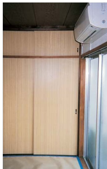
エアコン取付と建具の交換
