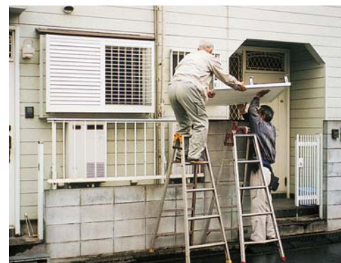
稼動式面格子(めんごうし)を取付ける様子
