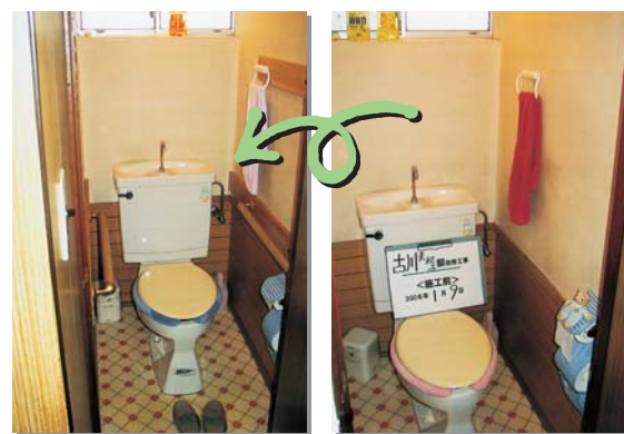
トイレの手すり
