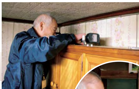
柱と食器棚にL型金具を 使用して固定しました。
