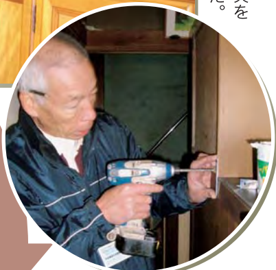
平形金具を使用し、上下の 棚を固定しました。
